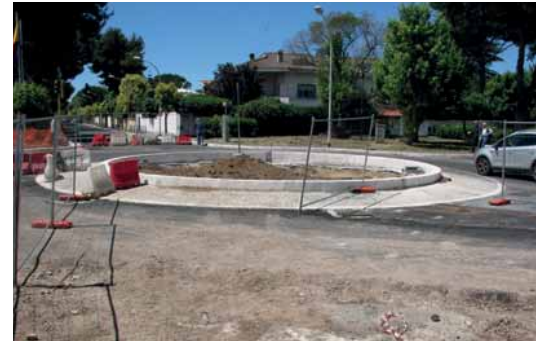
Ancora lavori in corso all'incrocio di via Eschilo con via Aristofane
