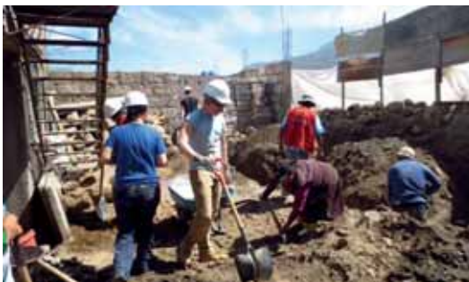
Costruendo i nuovi bagni a Ciudad de Dios, Arequipa
