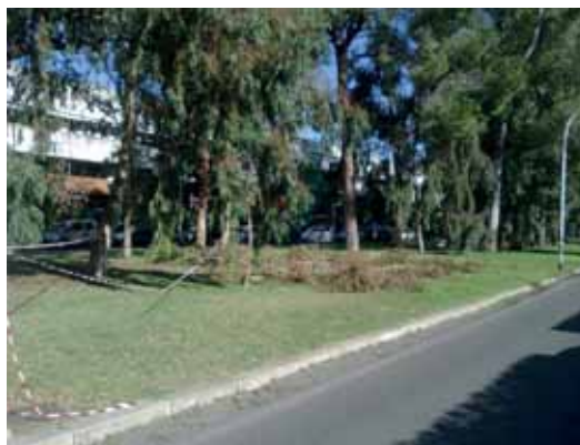
I recenti lavori del Consorzio su via Prassilla
