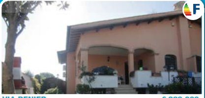
VIA RENIER € 299.000 Villa Angolare. Camere FUORI TERRA. Portico e Giardino.
