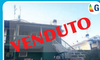
CASAL PALOCCO - VIA DIOFANTO Duplex superiore ristrutturato.
