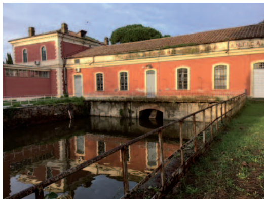
Impianto idrovoro di Ostia Antica
