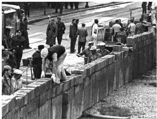
Il Muro in costruzione (1961)
