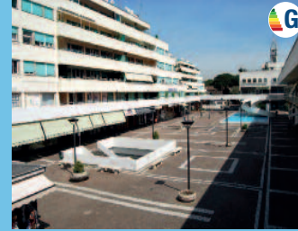
CASAL PALOCCO A partire da € 159.000 Locali commerciali diverse metrature.
