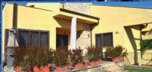
Via Castelli Porziano Villa Quadrifamiliare
