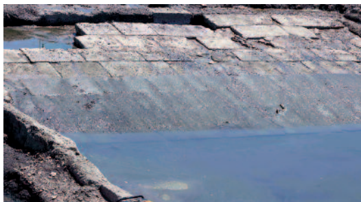
Rampa della vasca
