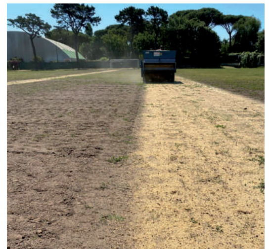
In preparazione della prossima stagione stiamo rifacendo il fondo del campo di calcio utilizzando sabbia di fiume drenante
