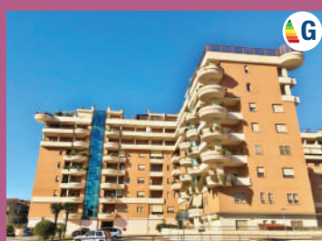
Axa- Terrazze del Presidente DA € 179.000 Appartamenti RISTRUTTURATI con giardino o terrazzo.
