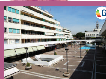
Le Terrazze vendita € 265.000 - affitto € 1.000 Locale commerciale 65 mq piano 1. Tre vetrine, termoautonomo.
