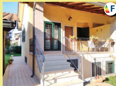
Dragona € 269.000 Villino capo schiera 120 mq recente costruzione. Patio e giardino perimetrale con posto auto.
