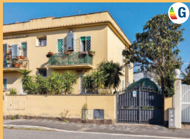
Infernetto €380.000 Cielo-terra 180 mq su due livelli FUORI TERRA, già divisa in due unità, giardino 400 mq.
