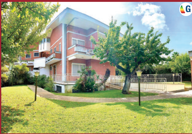
Casal Palocco € 639.000 Unifamiliare IN OTTIMO STATO di 280 mq con curatissimo giardino di 750 mq, box auto con comoda rampa di accesso e due passi carrabili. OTTIMA ESPOSIZIONE.
