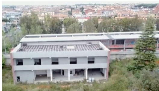
I Lavori, sospesi, della stazione di Acilia-Dragona
